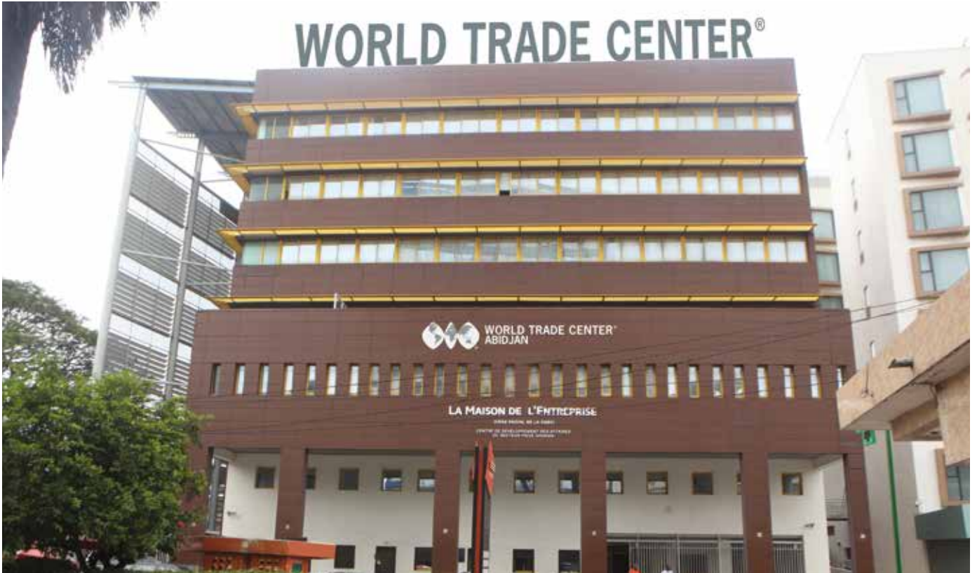
La Maison de l'Entreprise - Siège social du World Trade Center Abidjan
